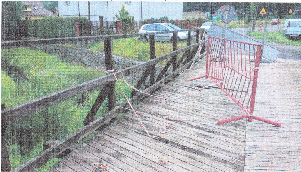
Most przed remontem (25.07.2017 r.):
