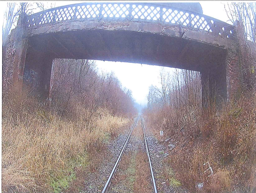
Fot. 3. Widok boczny na obiekt
