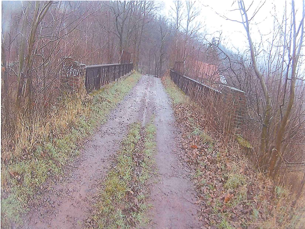
Fot. 1. Widok ogólny na wiadukt i na nawierzchnię
