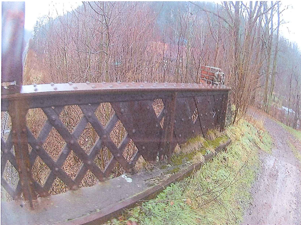
Fot. 2. Widok na barierę dla pieszych
