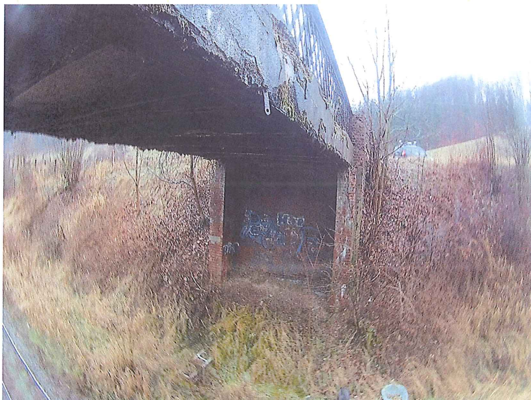
Fot. 4. Widok na wiadukt z perspektywy dolnej
